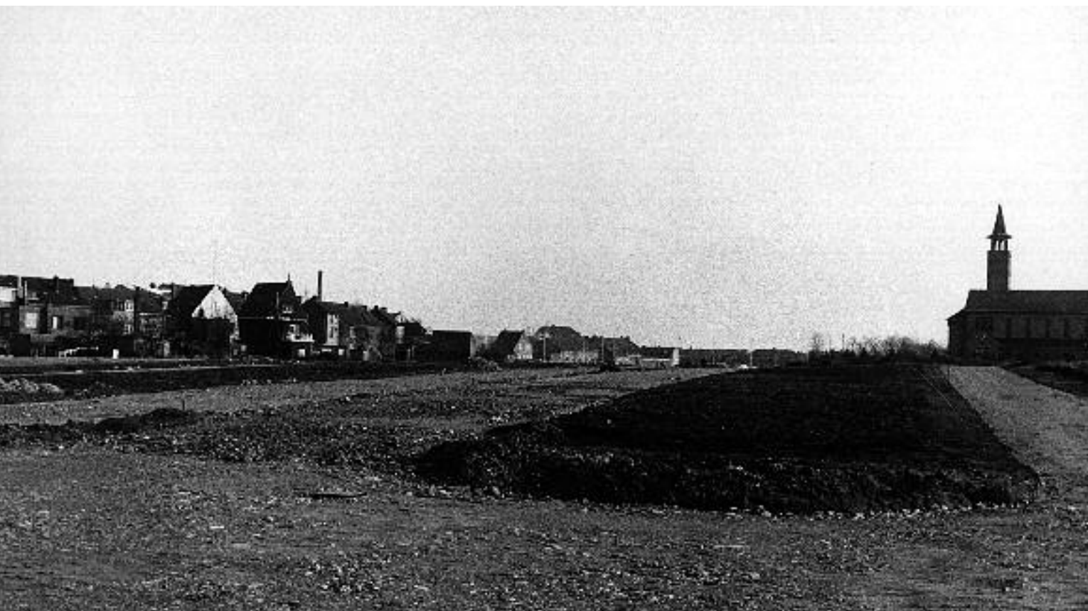
De aanleg van de Via Regia in Maastricht-West, met rechts het torentje van de kapel van het Sint-Annadalziekenhuis. Foto 1957.
